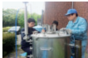
循環型蒸煮・蒸留器の 試運転の様子
