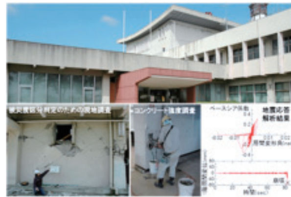
図2 被災建物の詳細調査と地震応答解析
