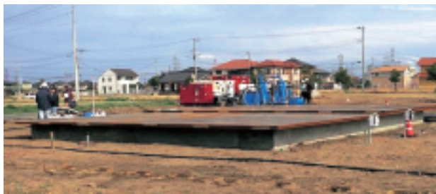
図 2. 液状化対策：地下水低下不飽和化工法による、地盤の液状化を防止するための試験施工の実施状況。
