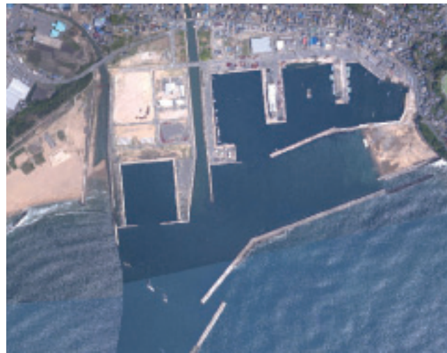
写真1 北茨城市久慈港の防波堤の倒壊状況 港口にあった防波堤が倒壊し散乱している。南向の防波堤のみに顕著な被害があった。(国土地理院、平成23年5月撮影)
