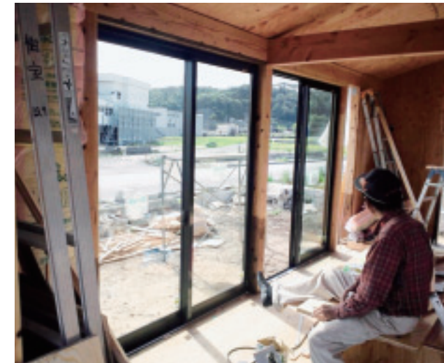
食堂建築作業の様子
