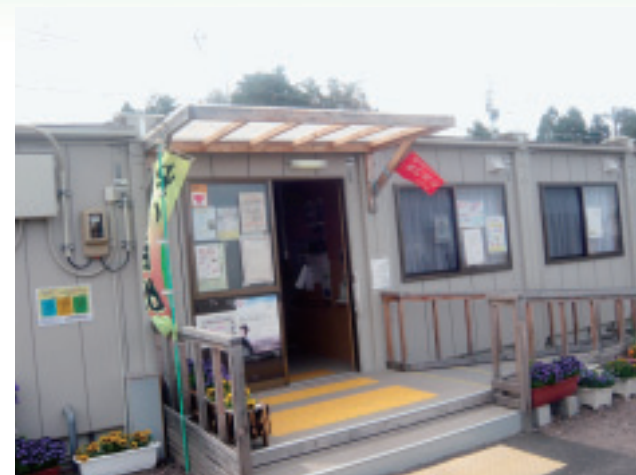
写真3 箱根仮設住宅集会所
