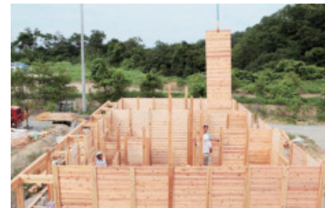
柱間にパネル化したスギの厚板を落とし込む
