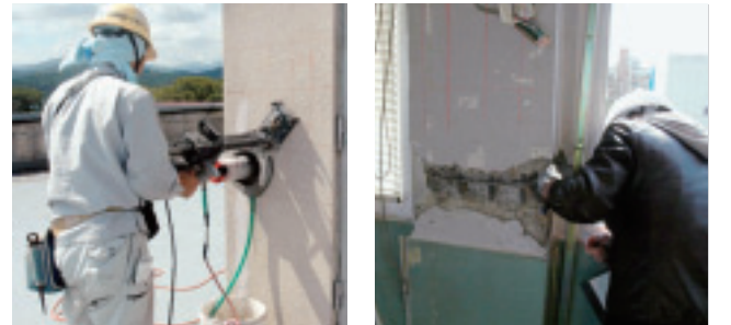
写真4 被害建物の詳細調査 継続使用が不可能となった建物の詳細な調査を行い、補強や取り壊しの判断の一助とする。左はコンクリート強度調査、右は鉄筋配筋調査。
